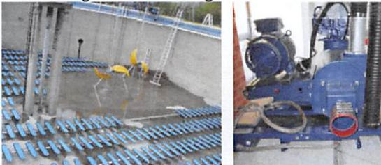
600 neue Belüftungselemente pro Becken und neue Belüftungsaggregate
